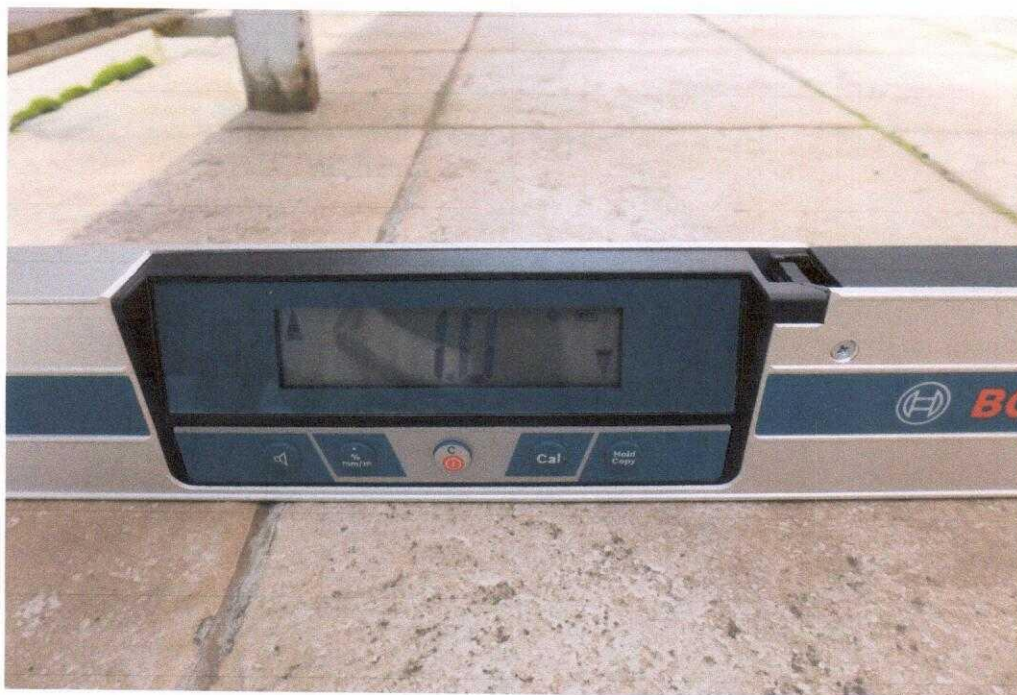
fot. 5. Pomiar nachylenia nawierzchni tarasu w % w innym miejscu
