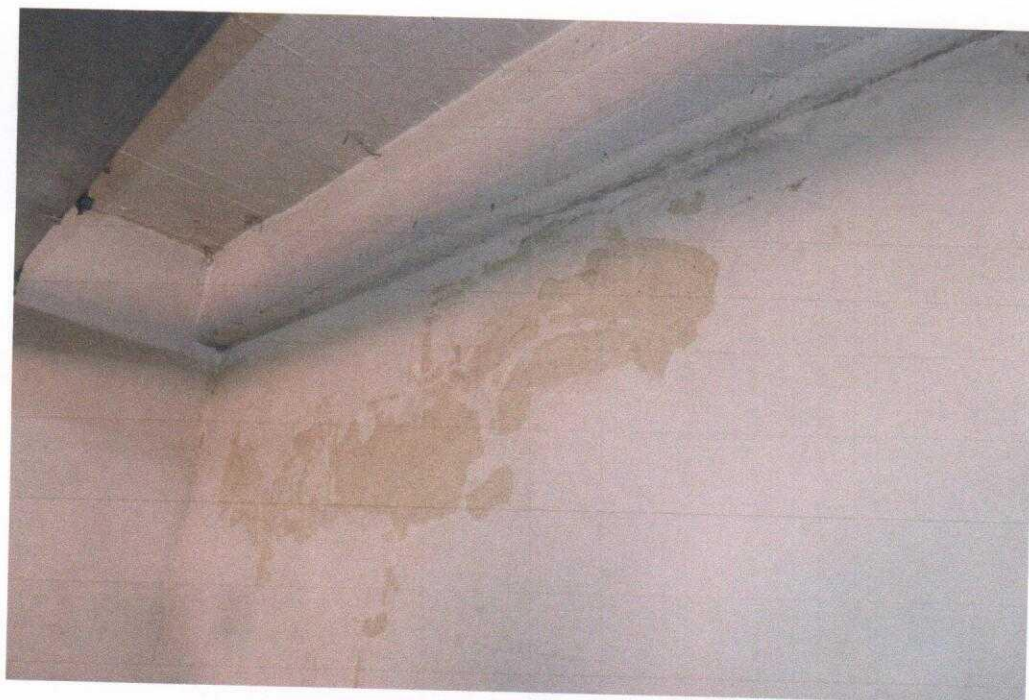
fot. 2. jw. w innym miejscu hali garażowej
